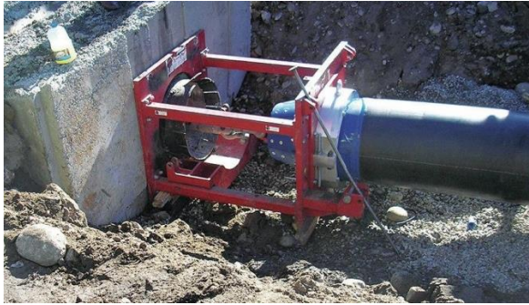
Рисунок 2. Обжимная матрица Swagelining
