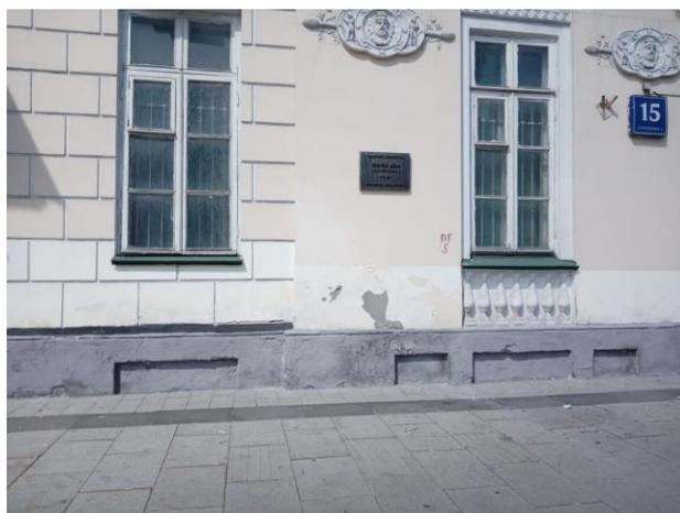
**Рисунок 3.** Фотофиксация разрушений и трещин на главном фасаде «Дома Протковой» нач. 19 века и оштукатуренного исторического ограждения Филатовской больницы, Садово-Кудринская, 15, ОКН
