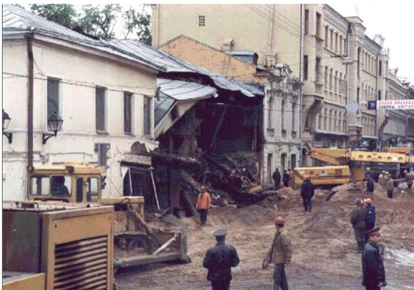
**Рисунок 5.** Разрушение здания, вызванное провалом, образовавшимся в результате выноса водонасыщенных несвязных пород в подземную горную выработку (Москва, 1998). Фото В.П. Хоменко [14]
