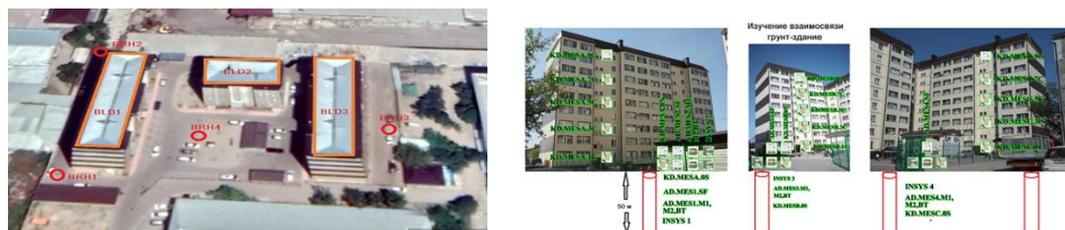
**Рисунок 7.** Система раннего оповещения от сильных землетрясений населения г. Бишкек
