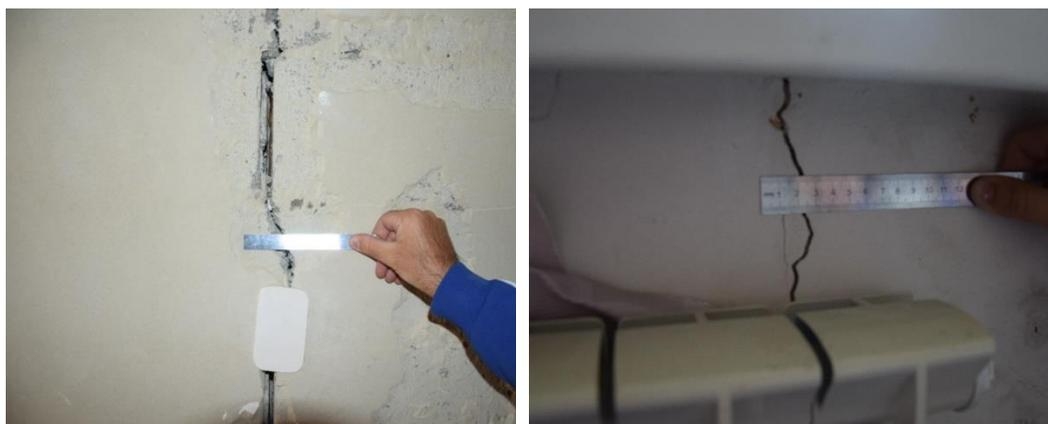
**Рисунок 1.** Сквозные трещины в несущих стенах. Результаты технического обследования жилого здания, оконченного строительством менее 3-х лет назад до момента настоящего обследования. Объект расположен на территории Ставропольского края
