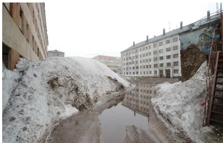
Рисунок 1 - Накопление снега у основания сооружения
