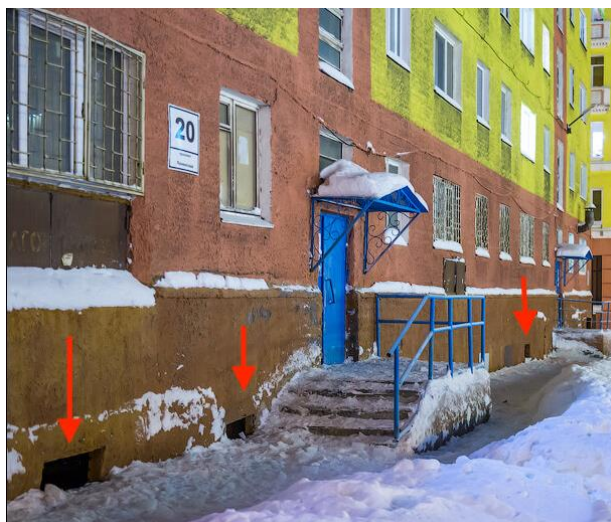
Рисунок 2 -Свободное вентилирование проветриваемого подполья, г. Норильск, 2021г.
