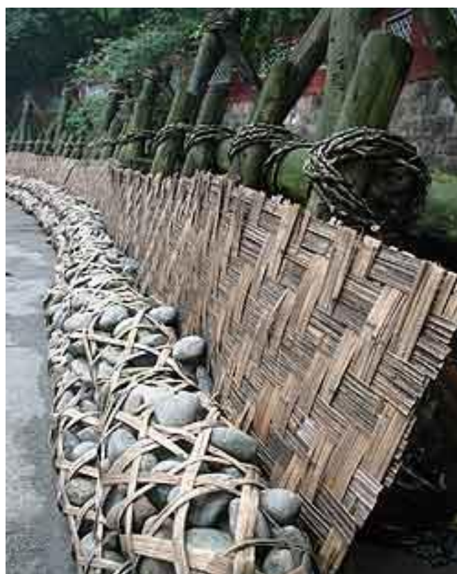
Рисунок 2 - Конструкция регулиционных сооружений Древнего Китая (реконструкция)
