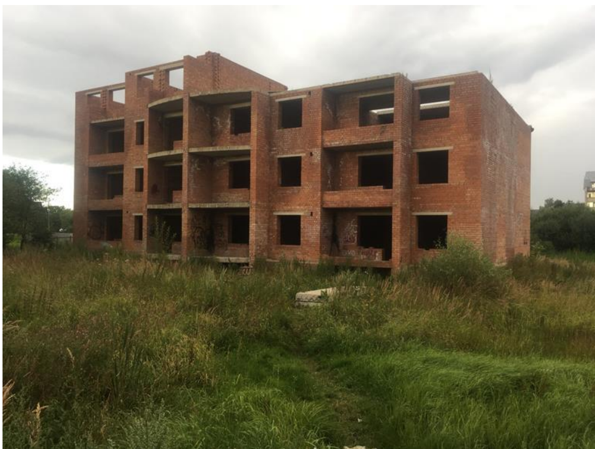
Рисунок 1. Общий вид недостроенного объекта Белоусово (фото автора)
