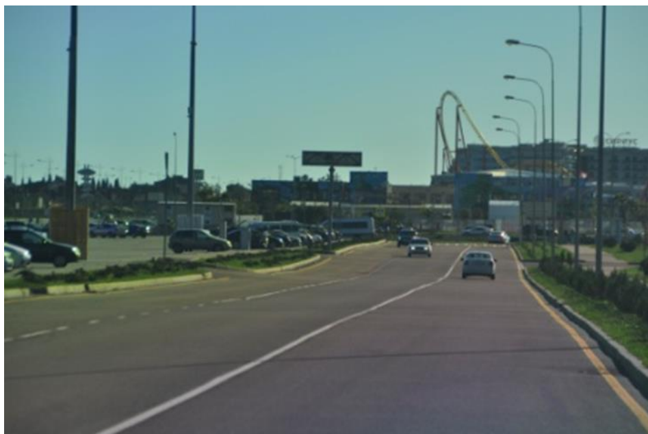
Рисунок 1. Видно существенное (до 1,2 м) плавное оседание дорожного полотна в результате остаточной консолидации грунтов основания.
