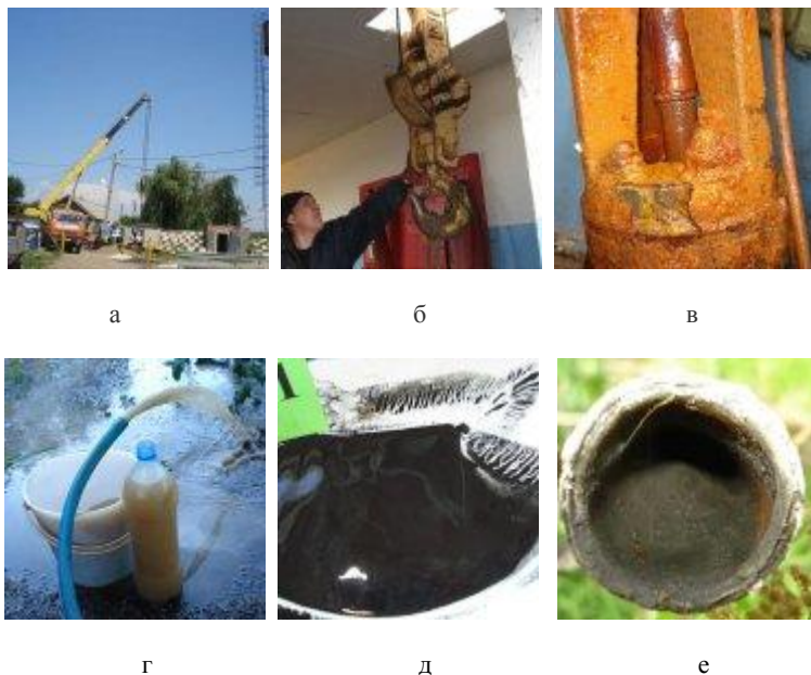
Рис. 2. Рабочие моменты закольматированных водозаборных скважин Саратовской области при техническом обследовании [8]:
