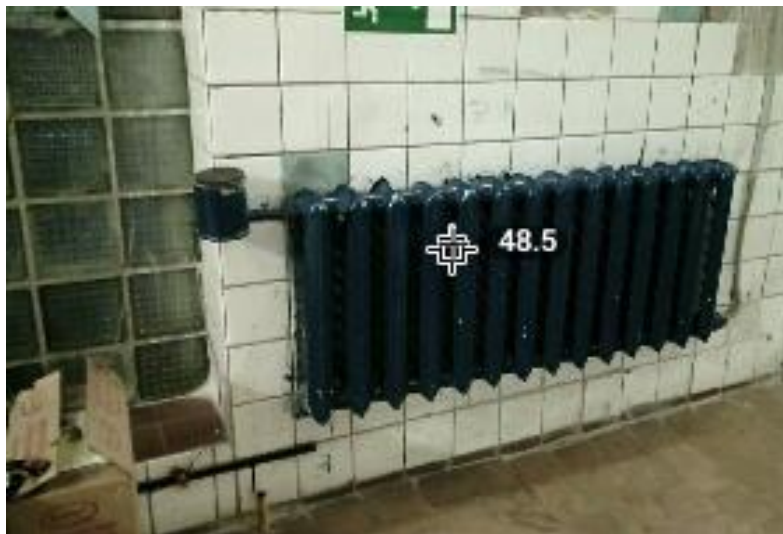
Рис. 1. Чугунный радиатор на КНС малой производительности (машинный зал)
