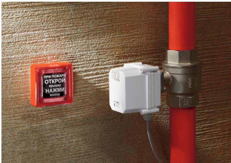
Рис. 3. Электромагнитный клапан системы антипротечки [6]
