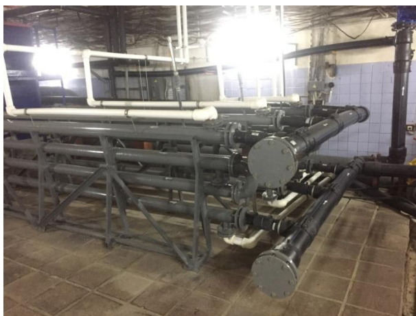
Рис. 5. Испарительный блок теплового насоса в КНС большой производительности
