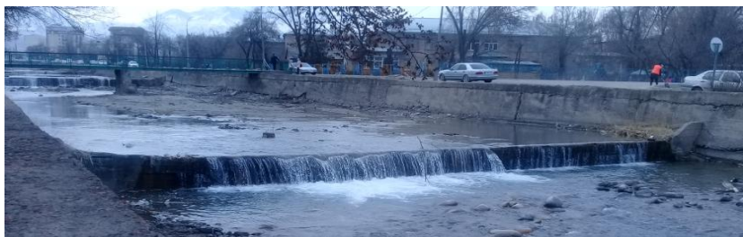
Рис. 1. На дне реки Ала-Арча имеется (например, по ул. Токтоналиева), широкий канал с высокими бетонными бортами, где на всю ширину предусмотрены бетонные пороги с перепадами, для ярусной ступеньки с горизонтальной поверхностью, предназначенные для понижения (энергии) скорости течения обильного потока воды, появляющегося в период половодья
