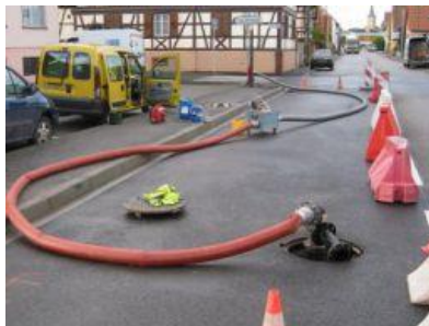
Рис. 11. Дезинфекция трубопроводов
