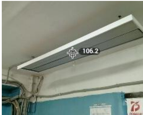
Рис. 2. Лучистая панель на КНС малой производительности (диспетчерская)
