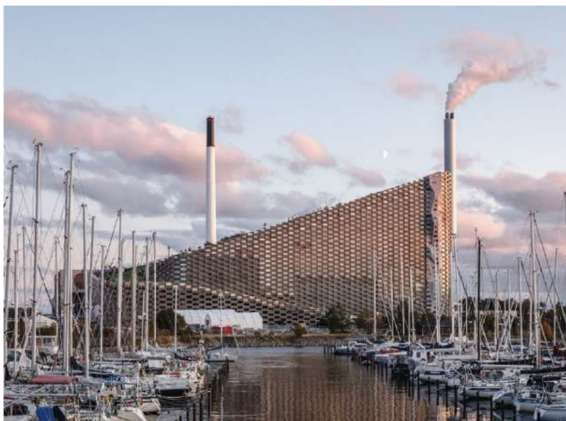
Рис. 1. Мусоросжигательный завод в Копенгагене (Дания).
