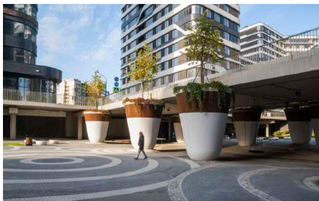
Рис. 8. Опоры моста – кадки для рябин
