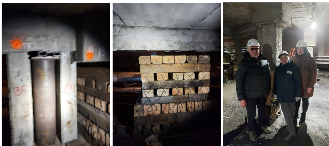
Рисунок 17. Подвальная часть здания Дворца культуры
