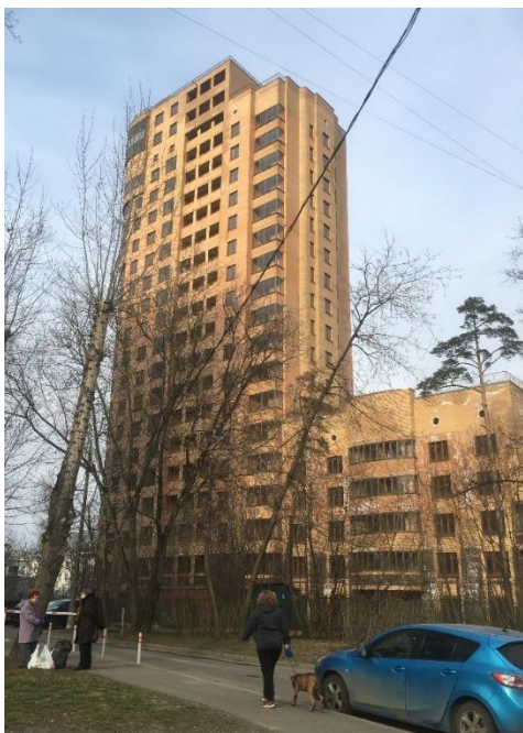
Рисунок 2. Общий вид объекта № 2 (фото автора 12.04.2021г)
