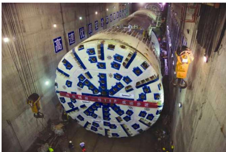
Рисунок 6. Горнопроходческий комплекс Robbins. Строительство ГЭС Jinping-II
