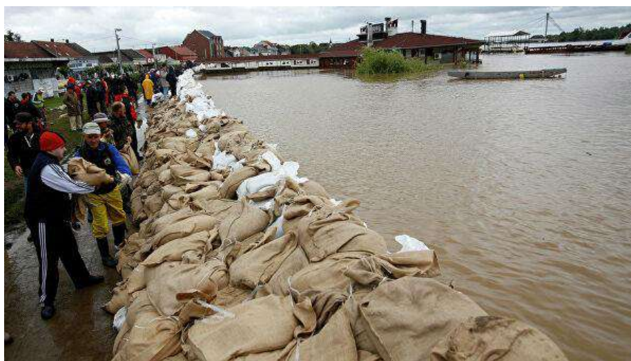
Рисунок 2. Плотина из мешков с грунтом
