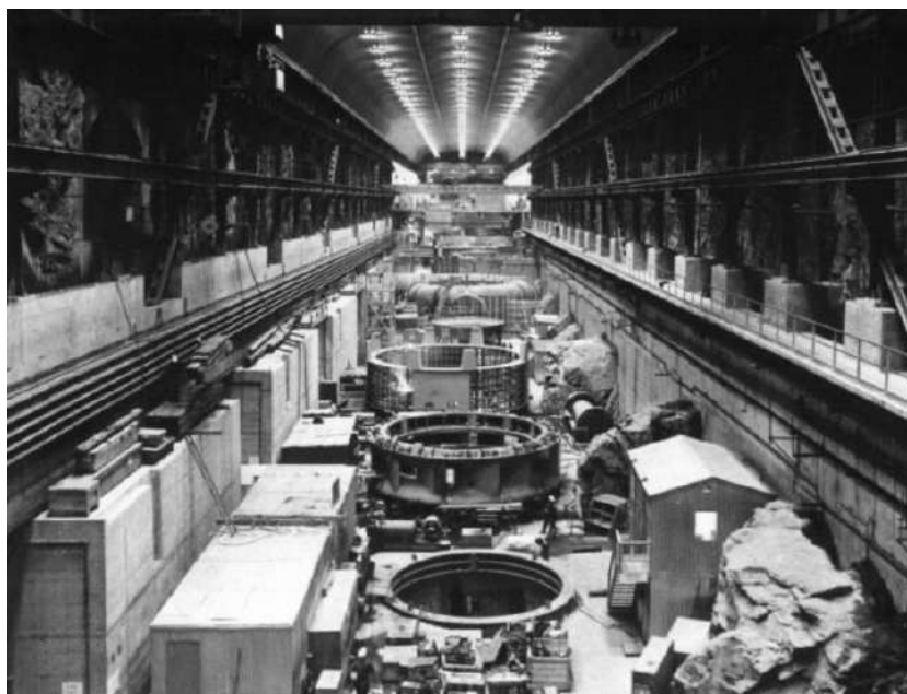
Рисунок 2. Машинный зал гидроэлектростанции Churchill Falls в период строительства (Канада)
