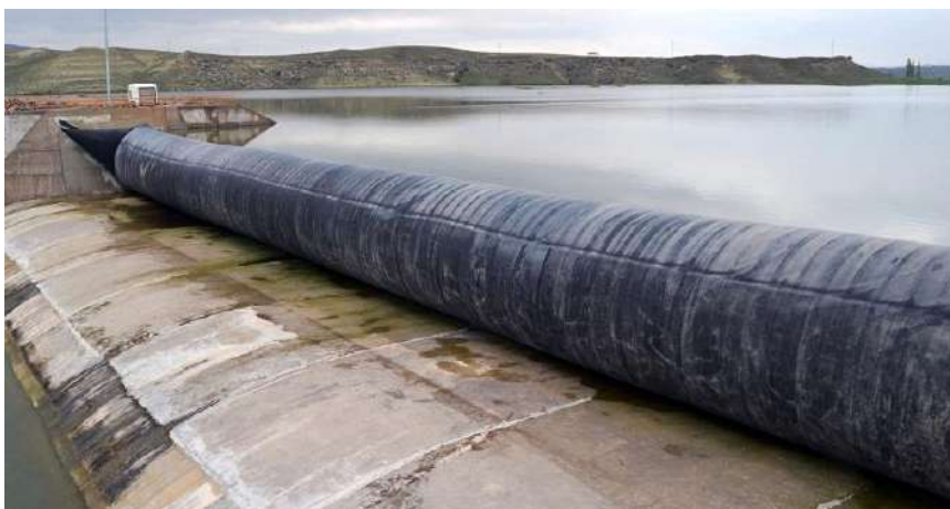
Рисунок 3. Быстровозводимая воздушнонаполняемая плотина
