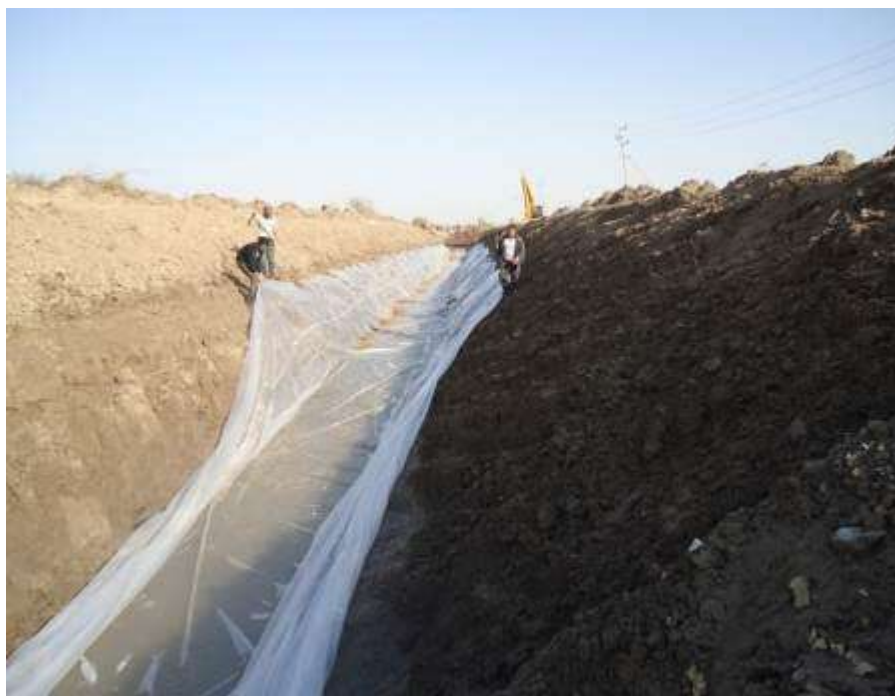
Рисунок 1. Укладка пленки для защиты от фильтрации.
