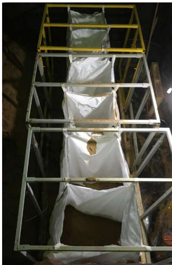
Рисунок 6. Металлические кондукторы (вид сверху)
