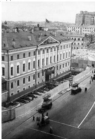
Рисунок 2. Перемещение здания Моссовета
