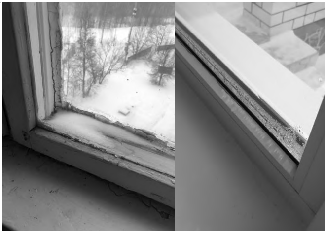
Рис.1 Слева – снег внутри стеклопакета старого деревянного окна, справа – конденсат на стекле герметичного окна
