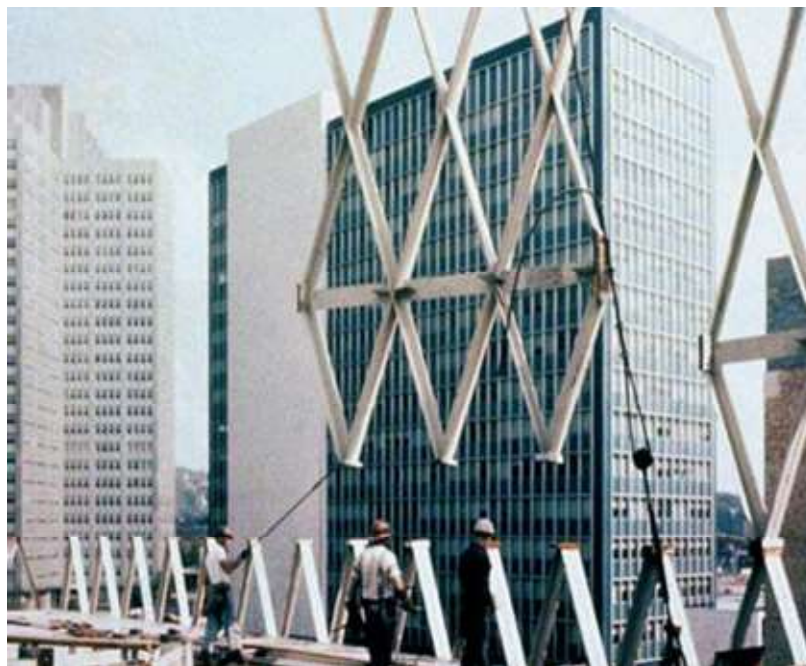
Рис. 2. Монтаж полносборной отправочной марки на строительной площадке. Строительство здания офиса IBM 1965 г
