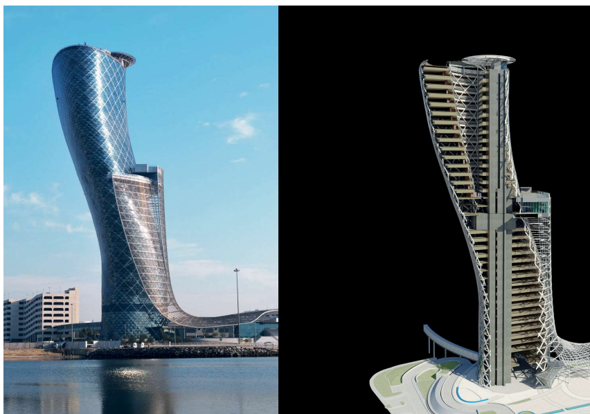
Рис. 7 Пример образования свободной формы при помощи системы Diagrid. Здание Capital Gate, ОАЭ Абу-Даби
