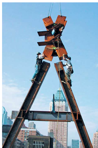
Рис. 3. Монтаж отдельного узла во время строительства The Hearst Tower в центре Манхэттена в Нью-Йорке
