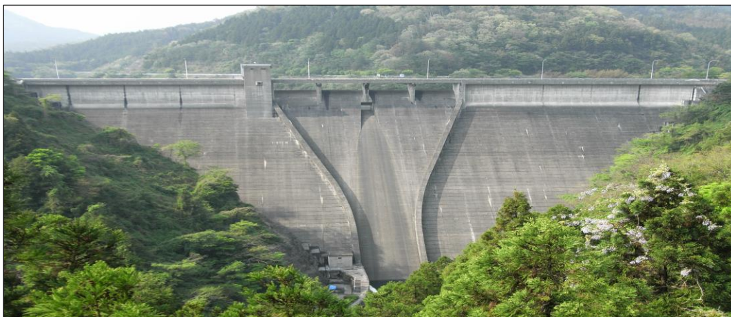
Рис. 1. Плотина Симадзигава - первая в мире плотина из укатанного бетона (Япония)
