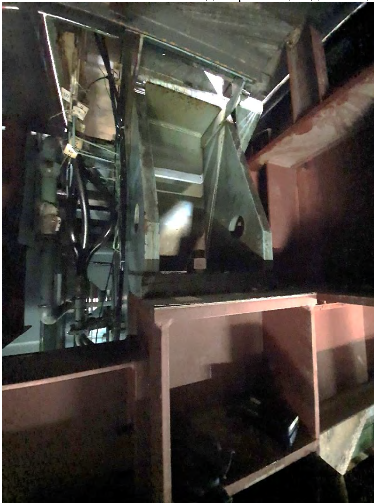
Рис. 3. Фотофиксация установки акселерометров на опору прессы
