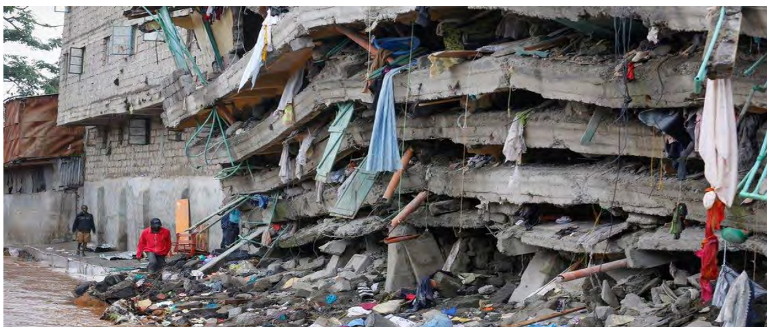
Рис. 3. Обрушившийся шестиэтажный жилой дом в г. Найроби
