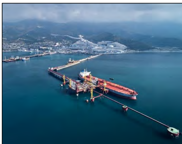
Рис. 1. Общий вид нефтеналивного причала
