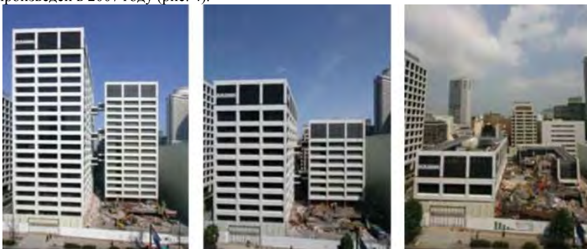
Рис. 4. Снос (демонтаж) здания по технологии «Срезать и опустить» [15]
