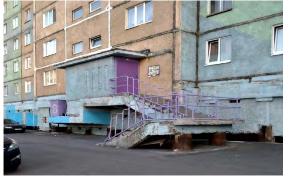
Рис. 4. Наружная лестница в жилом многоэтажном доме
