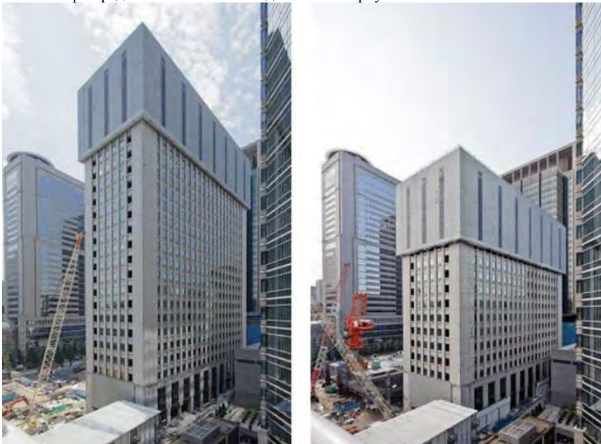
Рис. 5. Снос (демонтаж) здания по технологии «Тесогер» [15]
