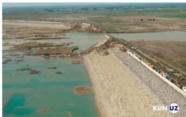
Рис. 1. Место прорыва воды в районе 6-го пикета Сардобинского водохранилища (Узбекистан). Фото ( https://storage.kun.uz/source/6/h7sUjgiotdeCRalzGiQXvXuG8RpVYL5a.jpg ).
