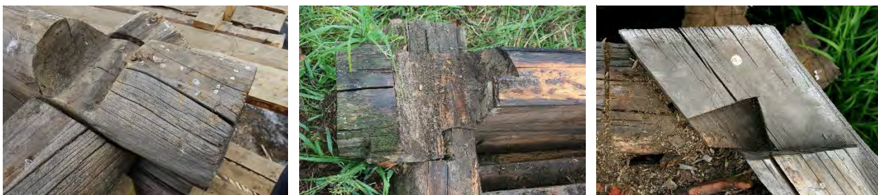
Рис. 2. Типы угловых врубок (соединений): а – «в чашу», б – «в крюк», в – «в лапу»
