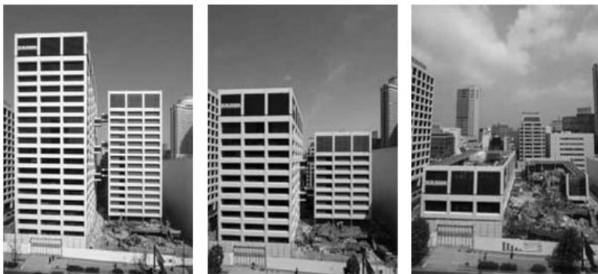
Рис.1 Демонтаж здания технологией “Срезать и опустить”
