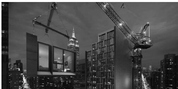
Рис. 1. Объемный блок во время монтажа в проектное положение
