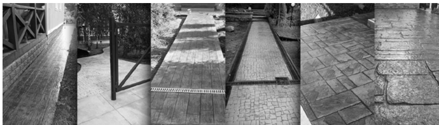
Рис.4. Дорожки из декоративного бетона
