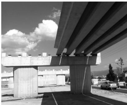
Рисунок 2. Строительство эстакады Рисунок 3. Сейсмоизоляция фундаментов от надземной части.
