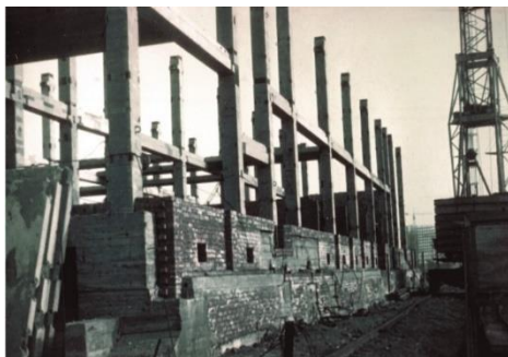
Рис.3. Часть строящегося здания АБК на поверхностном фундаменте-оболочке в г. Норильск
