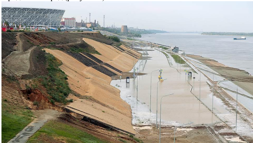
Рис. 1. Размыв откоса под действием дождевых и сточных вод
