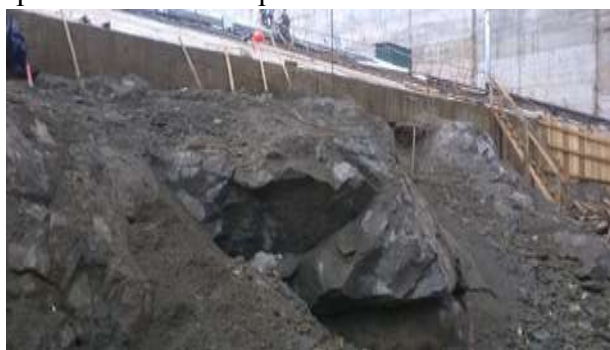
Рис.2. Неочищенная скала от грязекаменной массы. Средняя часть наклонной плоскости.
