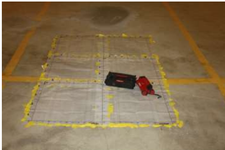
Рис.2. Обследуемая поверхность (верх плиты перекрытия) с нанесённой на нее разметочной сеткой.
