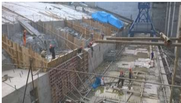
Рис.5. Армирование бетонного блока. Подготовленный ряд блоков для заливки их бетоном
