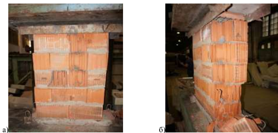
Рис. 4 Характер разрушения образцов
