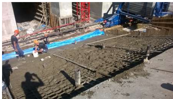
Рис.6. Бетонирование блока. Процесс создания ровной поверхности.
