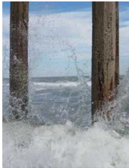
Рис. 1. Повреждение железобетонных гидротехнических сооружений во Вьетнаме в результате коррозии в морской воде
