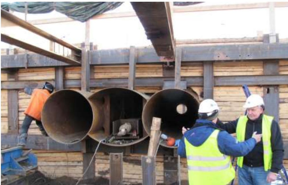
Рис. 1. Устройство защитного экрана из трех секущихся труб
