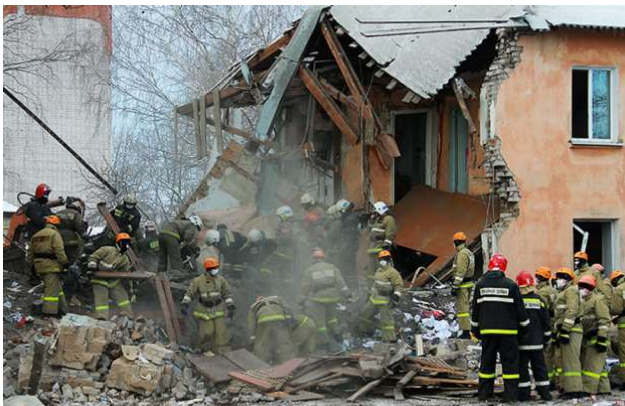
Рис.1. Последствия взрыва бытового газа в квартире (первый этаж) двухэтажного здания жилого дома (г. Иваново).
