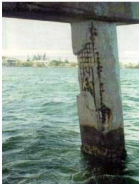
Рис. 1. Повреждение железобетонных гидротехнических сооружений во Вьетнаме в результате коррозии в морской воде
