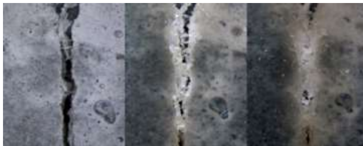
Рис.4 Процесс заполнения трещин.
