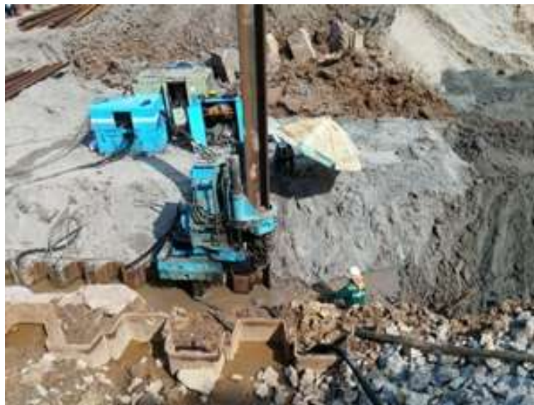
Рис. 2. Устройство ограждения котлована шпунтом Ларсена на объекте Imperia сад - 203 Нгуен Зуй Тьонг - Тхань Суан - Ханой
