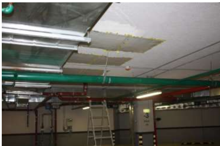
Рис. 3. Обследуемая поверхность (низ плиты перекрытия) с нанесённой на нее разметочной сеткой
