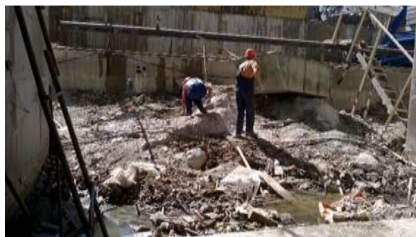
Рис.3. Неочищенная скала от грязекаменной массы и строительного мусора. Нижняя часть наклонной плоскости прямо над верхним урвнем
