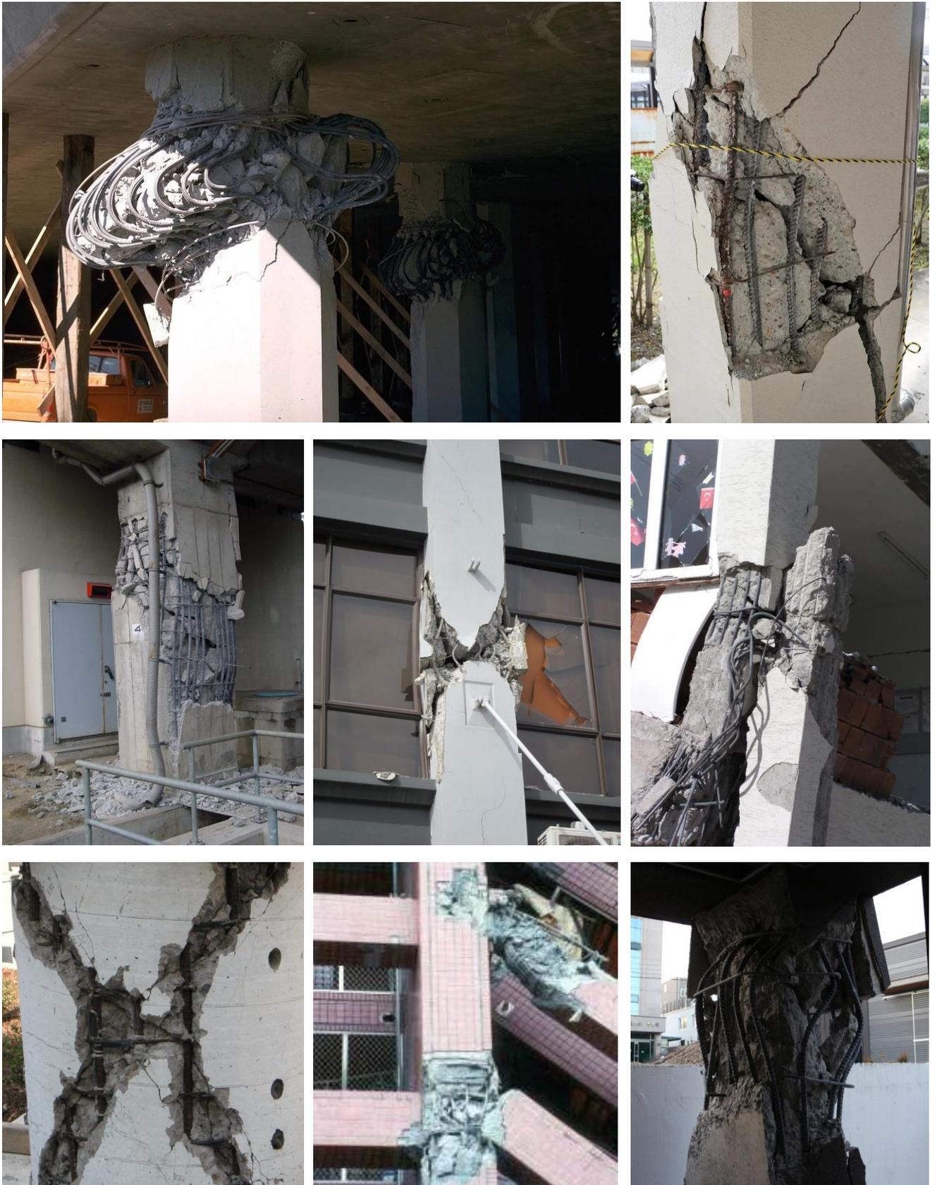
Рисунок 1.6 – Повреждения железобетонных элементов и узловых соединений каркасных зданий при сейсмических воздействиях
