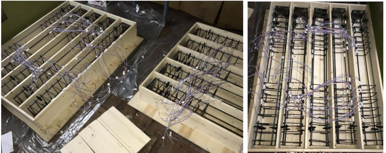
Рисунок 2.2 – Арматурные каркасы в опалубке
