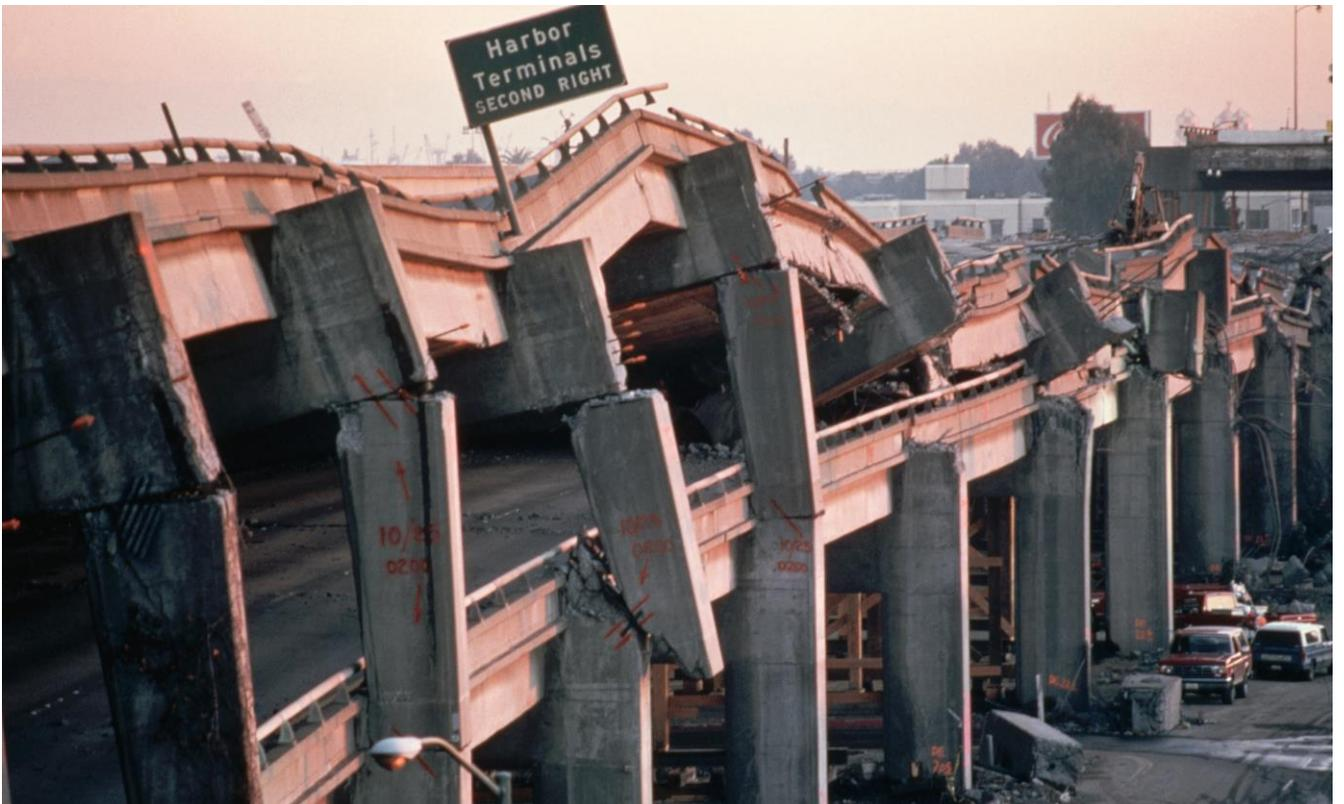
Рисунок 1.8 – Разрушенные опоры моста в Окленде, США. 1989 год
