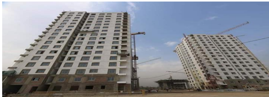
Рис. 4.3. Строительство жилого комплекса «Ворота Ирака»
