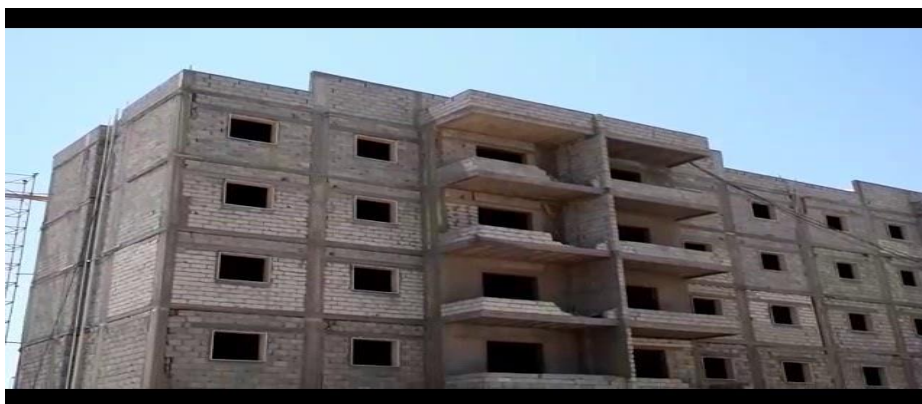
Рис. 4.4. Строительство жилого комплекса «Джабал Амель»
