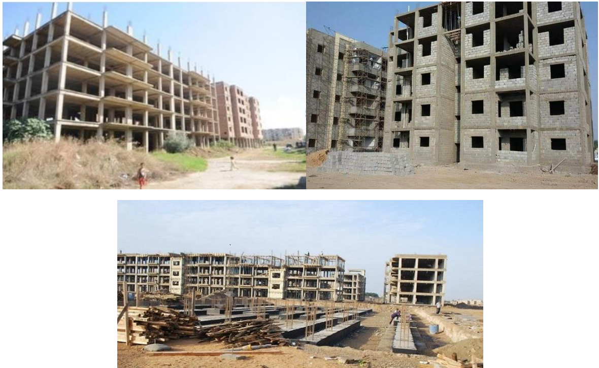
Рис. 1.9. Незавершенное строительство из-за финансового кризиса 2015 года
