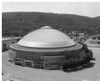
Рис.4. - Павильон, построенный в 1959г. для ярмарки в г. Брно (Чехия)
