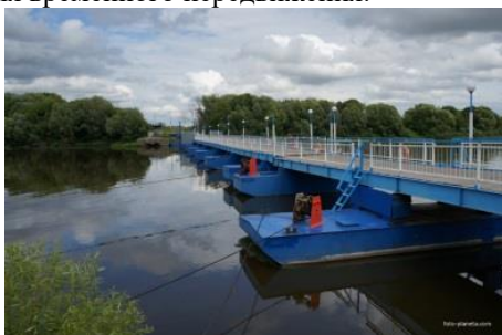
Рис.4. - Голутвинский понтонный мост
