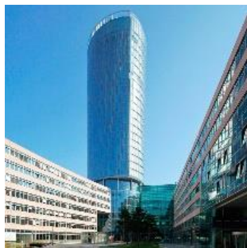
Рис.6. - Башня делового центра
