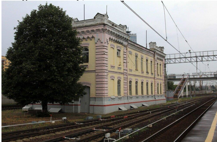
Рис. 1. Здание железнодорожной инфраструктуры, подвергающееся динамическим воздействиям
