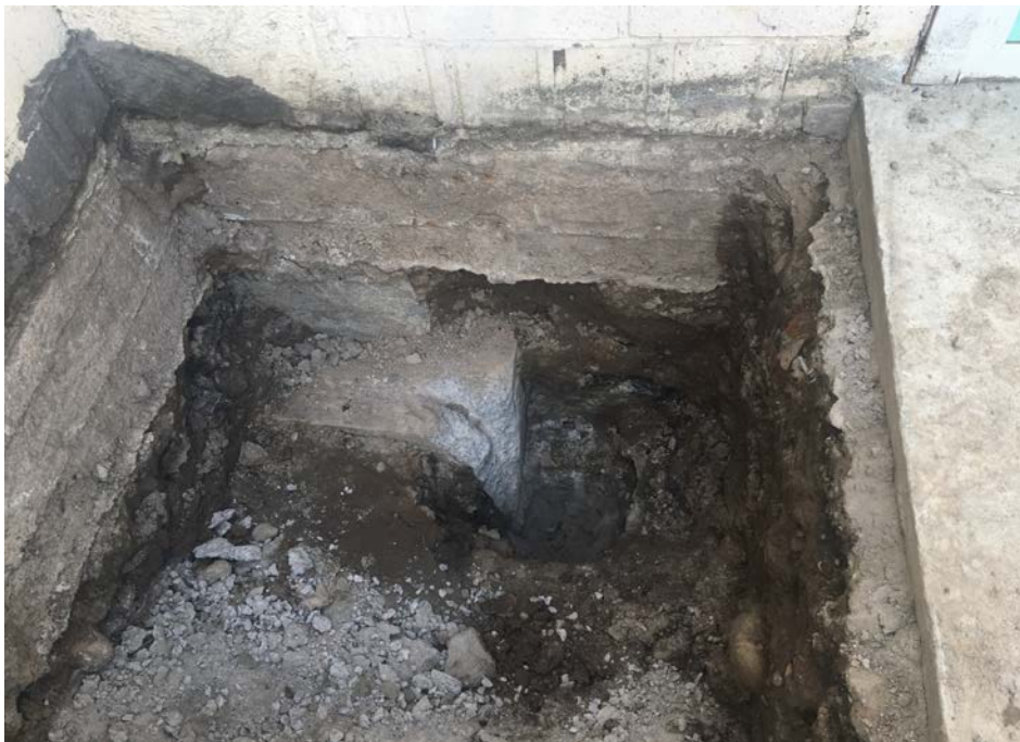
Рис. 2. Фундамент по оси И и по температурному шву 3-4. Вид 2
