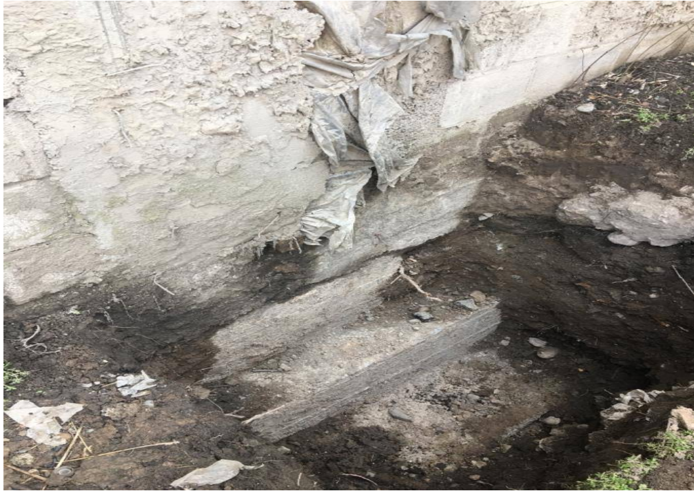
Рис. 4. Фундамент по оси М и температурному шву 4-3
