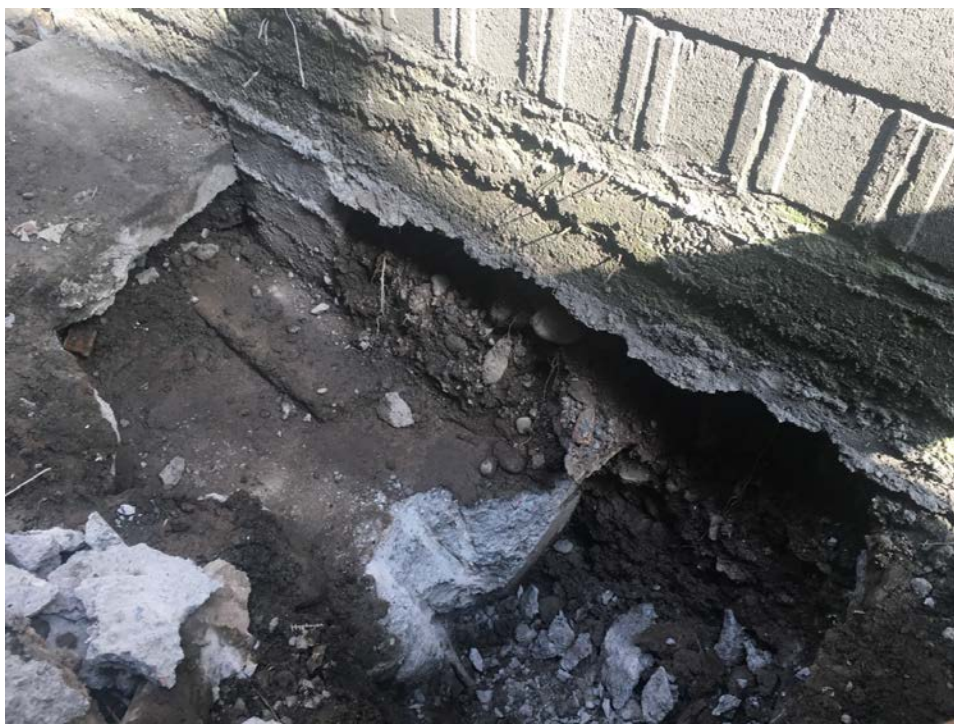
Рис. 3. Фундамент по оси 1-Г
