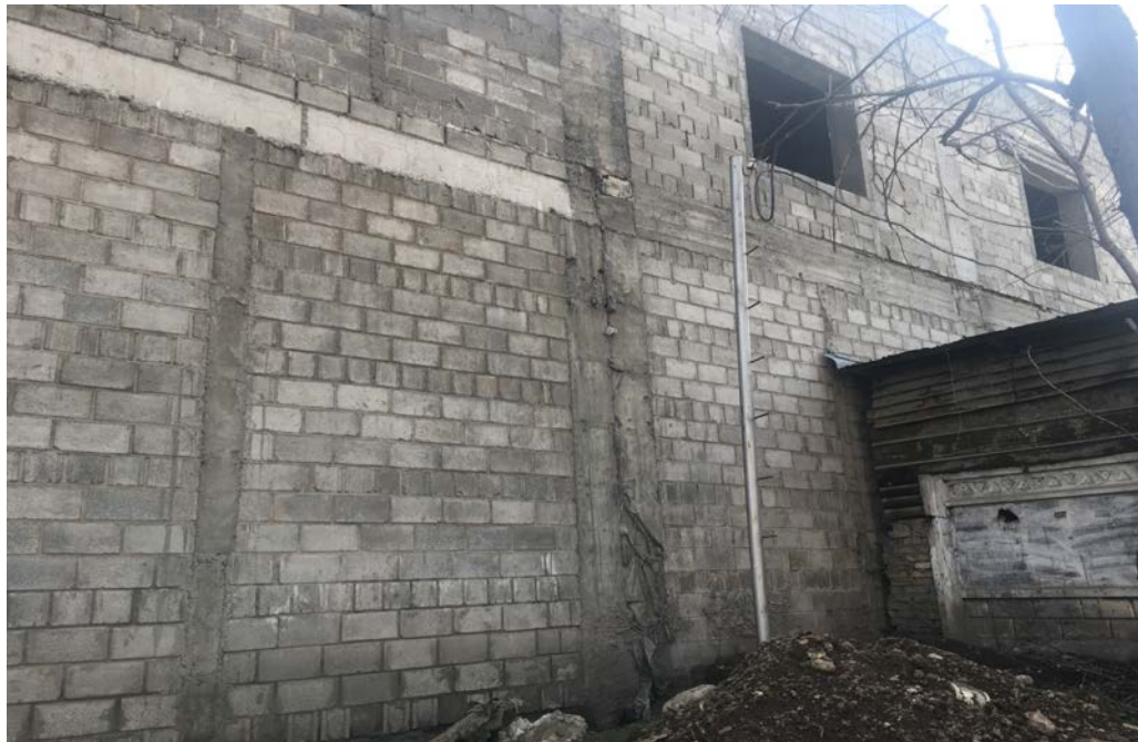
Рис. 5. Температурный шов по оси М и 4-3. Вид 1
