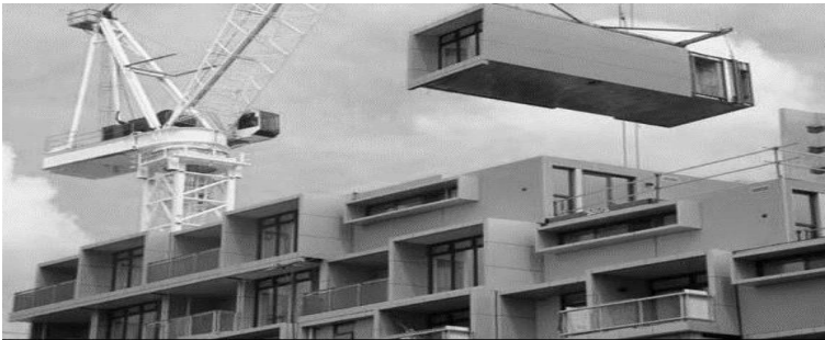
Рис. 2. Процесс монтажа модуля в проектное положение
