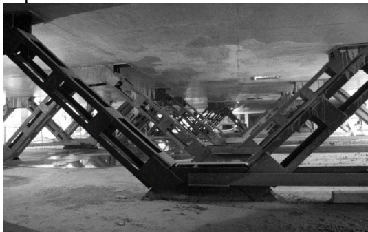
Рис. 1. Временная пространственная стальная конструкция, выполненная при строительстве 6-тиэтажного подземного паркинга на Тургеневской площади.
