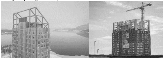
Рис. 1. Строительство деревянного высотного здания в Норвегии
