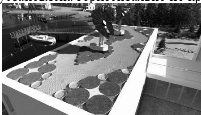
Рис. 2. Модульная система озеленения кровли здания
