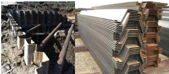
Рис. 1. - Шпунтовое ограждение
