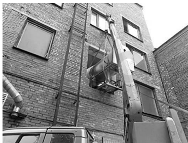
Рис. 2. Монтаж крупногабаритное медицинского оборудования
