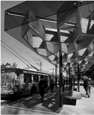
Рис.2. Остановка из клееной древесины в Канаде
