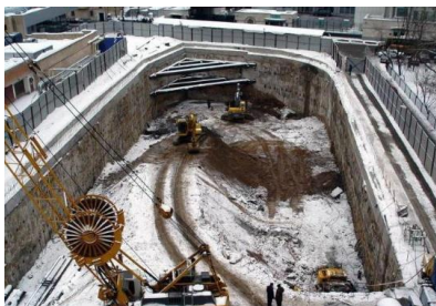
Рисунок 2. Ограждение – «стена в грунте».
