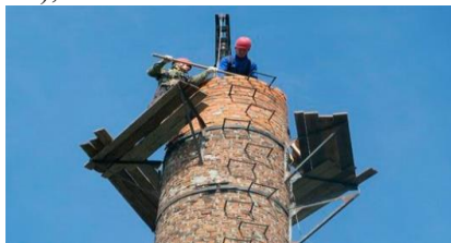
Рис. 1. Ручной демонтаж дымовой трубы
