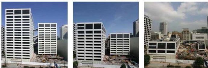
Рис. 3. Демонтаж здания по технологии «срезать и опустить»
