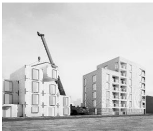
Рис. 1. Монтаж объемного блока в проектное положение
