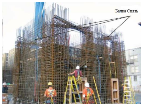
Рис 1. Диагонально армированные соединительные балки
