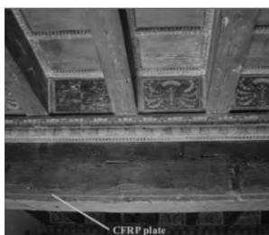
Рис. 1. Усиление деревянных балок перекрытия:
