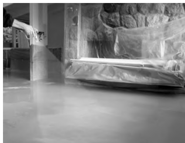
Рис.4 Обработка гладкой поверхности пола специальным составом для предотвращения потери влаги
