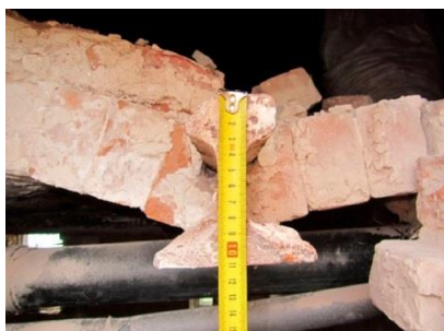
Рис.2 Стальной рельс в конструкции междуэтажного перекрытия
