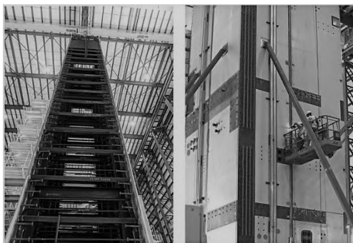
Рис.1 Субмодуль стены АЭС Саньмэнь. Китай. Дата постройки 2018г.
