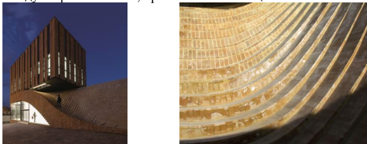
Рис. 4. Многофункциональный коммерческо-офисный дом, г. Хамадан: а- общий вид, б –кладка кровли
