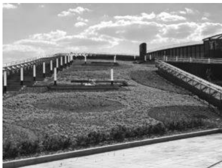
Рис. 3. Зеленая кровля павильона станции метро «ЦСКА»
