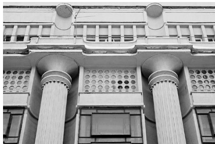
Рис. 1. Фрагмент фасада Центральной подстанции
