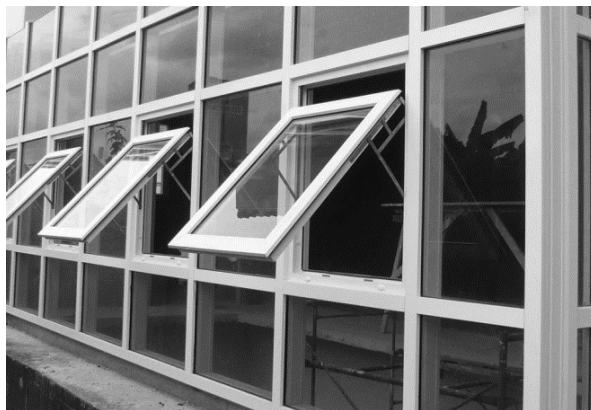
Рис. 2. Легкобрасываемые оконные конструкции
