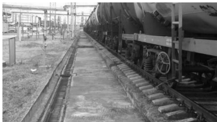
Рис. 2. Ограждение площадки под эстакадой бетонным бортиком.
