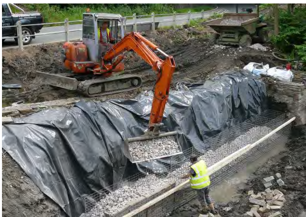
Рис. 2. Работы по укреплению берега
