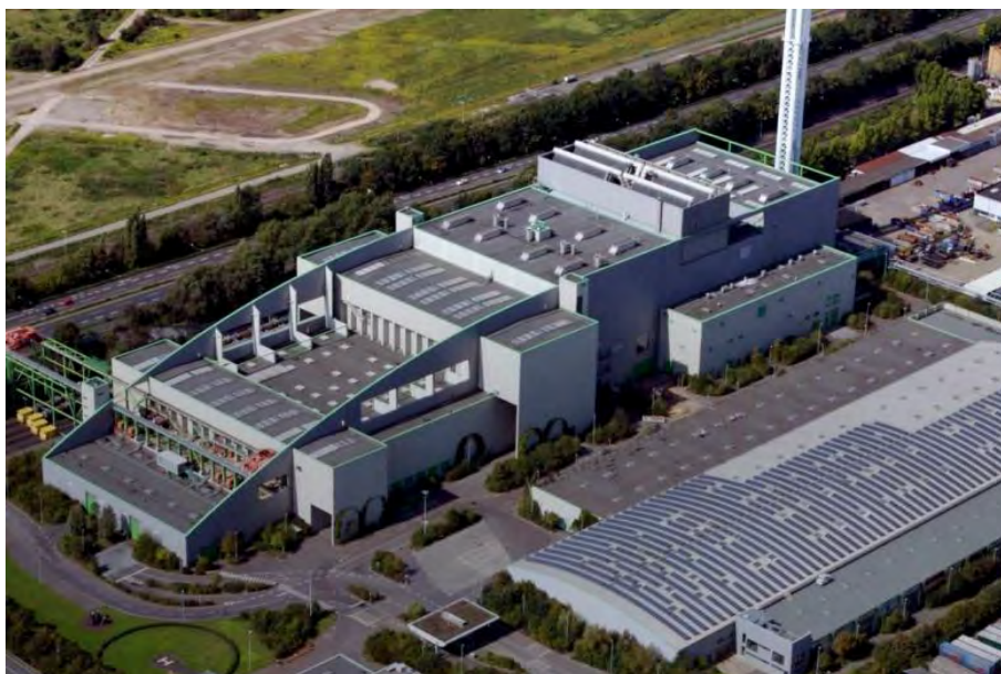
Рис. 2. Завод по термической переработке мусора AVG Köln (Германия)
