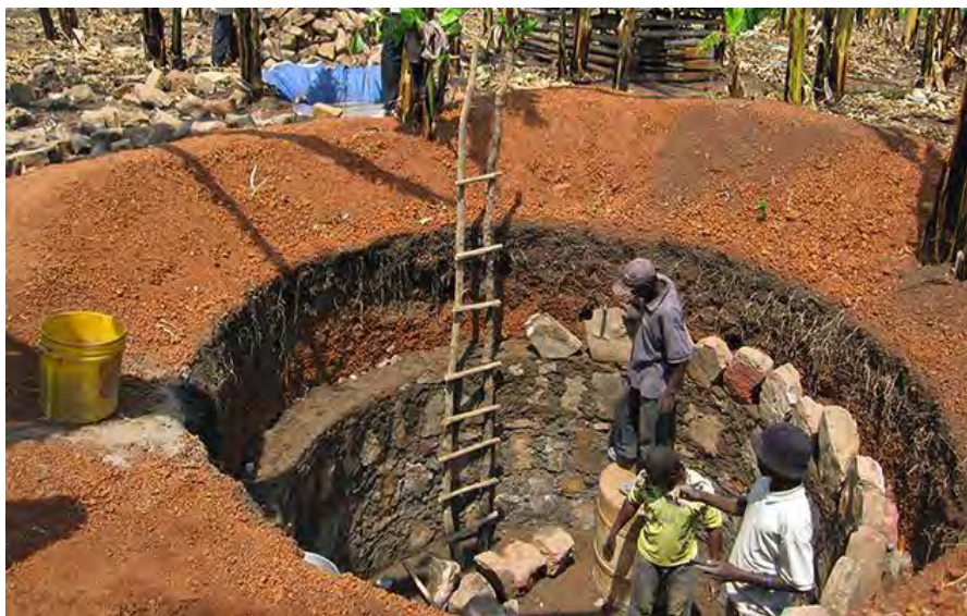
Рис. 6. Устройство резервуаров для воды
