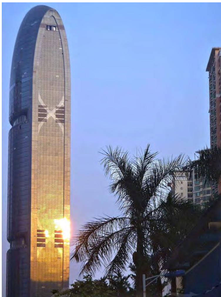
Рис. 5. Выработка электроэнергии при закрытых жалюзи ( www.magspace.ru )
