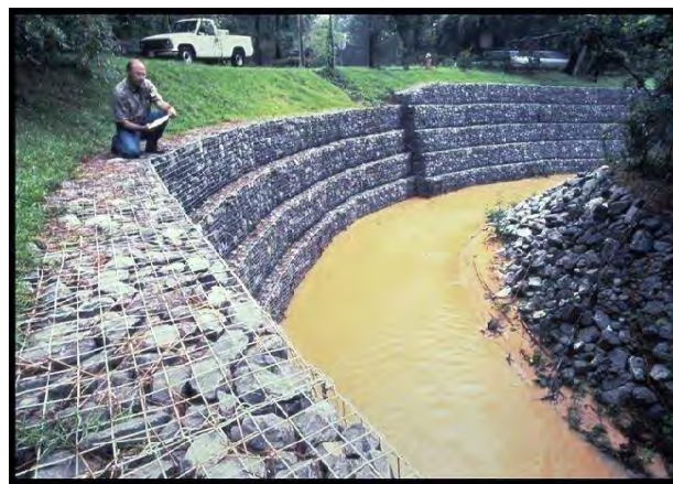
Рис.3. Ступенчатая кладка
