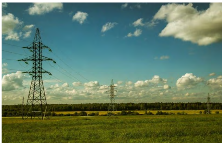
Рис.1. Линии электропередач, установленные на полях
