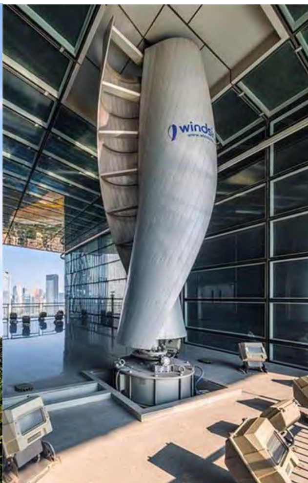
Рис. 2. Ветрогенератор, интегрированный в конструкцию здания ( www.pinterest.com )
