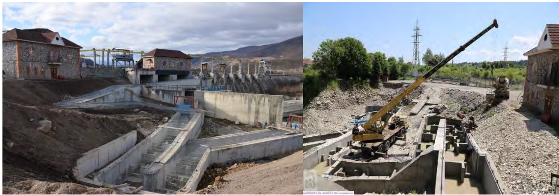
Рис.2. Головной узел Аушигерской ГЭС
