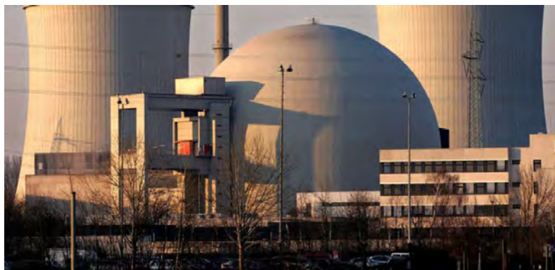
Рис.12. Атомная станция в Любмине (Германия)
