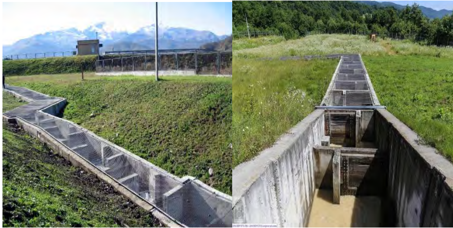
Рис.1. Рыбоход на головном узле Кашхатау ГЭС
