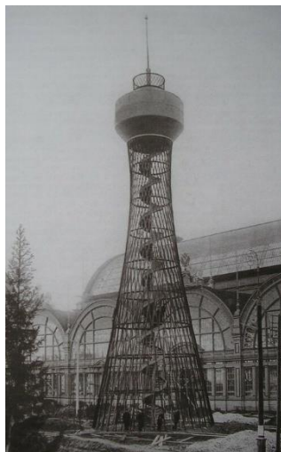
Рис.4. Башня Шухова в Полибино
