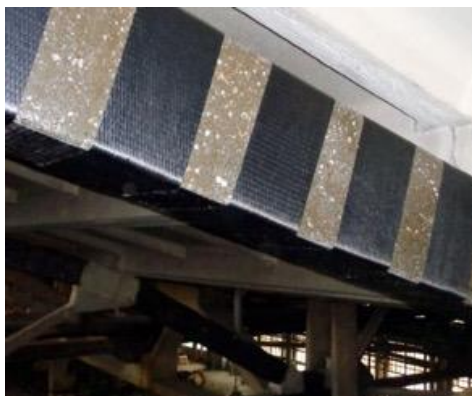
Рис. 1. Усиление балки волокнистыми композитами
