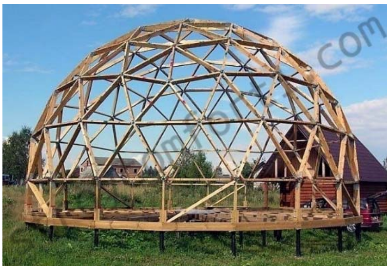
Рис. 5. Каркас купольного дома
