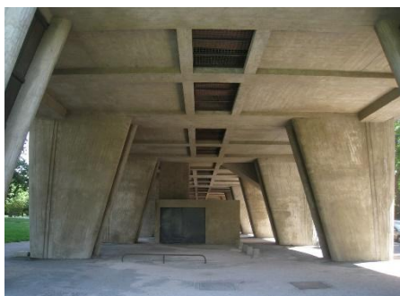
Рис. 3. Столбы-опоры Марсельской единицы во Франции, Ле Корбюзье
