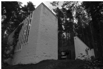
Рис. 2. Вид на дом с юго-запада
