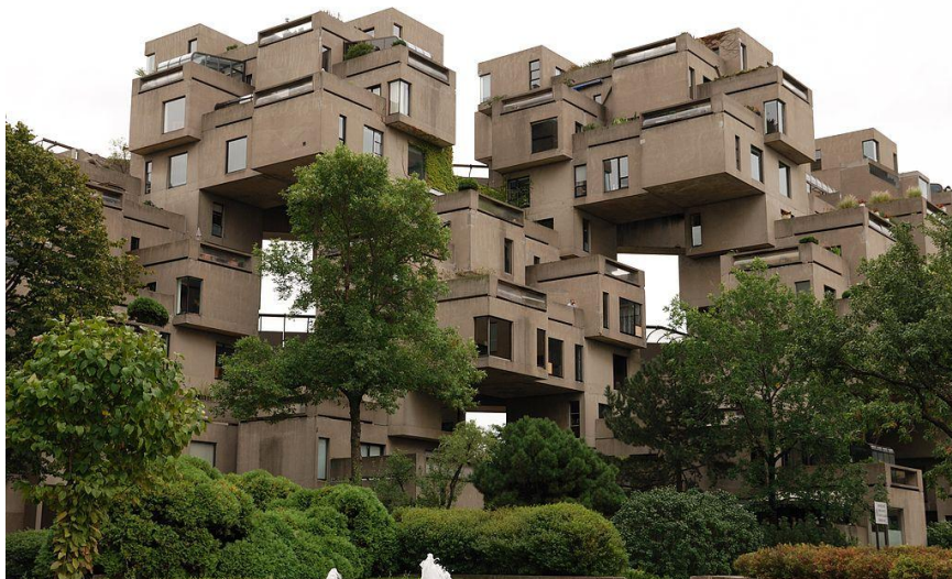
Рис.2 146-квартирный жилой комплекс Хабитат 67 из 345 железобетонных кубов-модулей.
