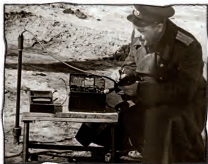
Измерение прогиба поверхности грунта под нагрузкой На полигоне. 1957 г.
