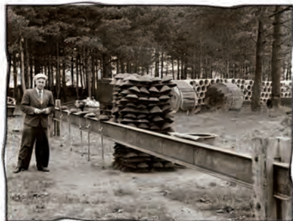
Измерение прогиба поверхности грунта под нагрузкой На полигоне. 1957 г.
