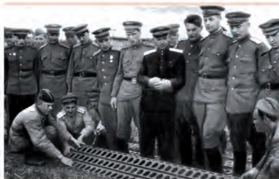
Устройство посадочной полосы
